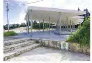
海浜公園休憩施設新築工事
